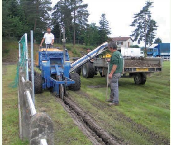
Actuellement, les stades de foot bénéficient d'un entretien complet. Dans un premier temps, l'arrosage automatique est réalisé sur les 2 stades : 7 rampes de 5 arroseurs pour le stade de jeu et 6 rampes de 5 arroseurs pour le stade d'entraînement.
